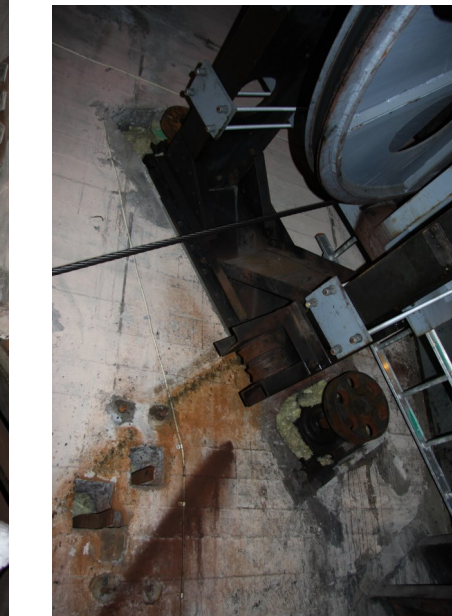
Drivverksrommet. Drivverket som brukes er det samme som i 1928, men de to hjulene for trekk-kabelen er erstattet av ett nytt.
