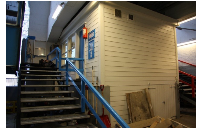
Trapp opp til den ene vognen og kontorbrakken fra 1991 hvor det opprinnelig var kjøreport.
