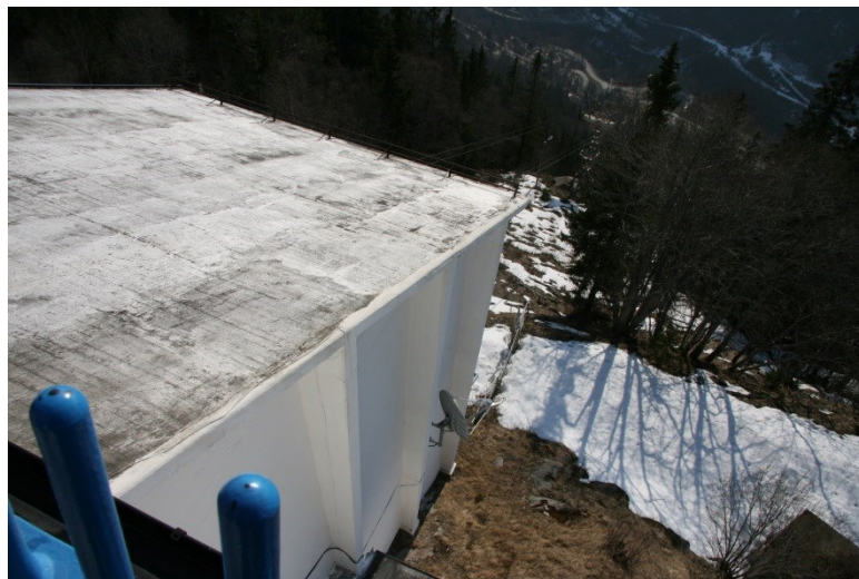
Vognrommets eksteriør sett fra takterrassen.
