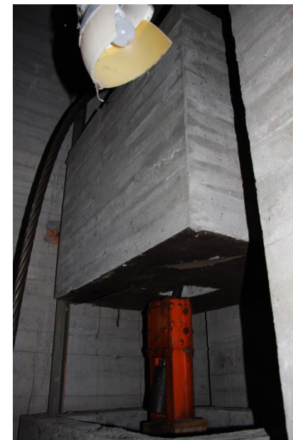
Lodd i østre sjakt.
