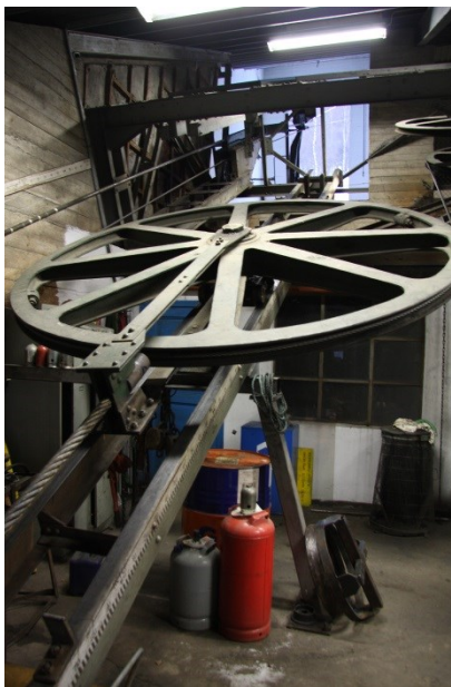
Drivverk med løpehjul og ut og inngangshjul og åpning for vogn nr. 1 i øst. Verkstedsrom ses i bakgrunnen.
